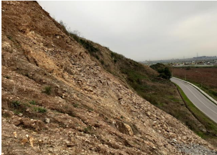
Figura 9.5. Deslizamiento de suelo y roca en el sector de cerro La Peña- Yobilo, comuna de Coronel, Región del Biobío.
