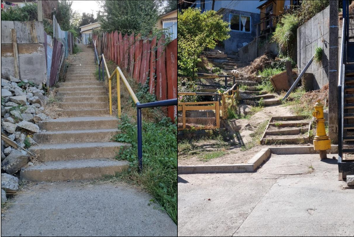
Figura 19: Fotografías del estado actual de las escaleras del barrio
