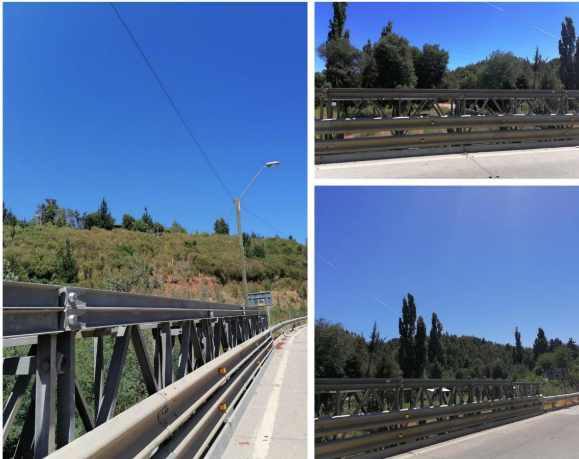
Figura 20: Fotografías de puente ubicado en la localidad de Roa
