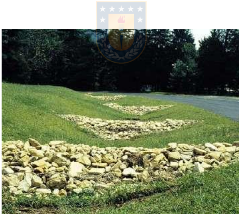
Figura 2.- Cuneta revestida con vegetación ( grassed swale ) con embalse de chequeo ( check dam ). (Fuente: DERN, 2007)
