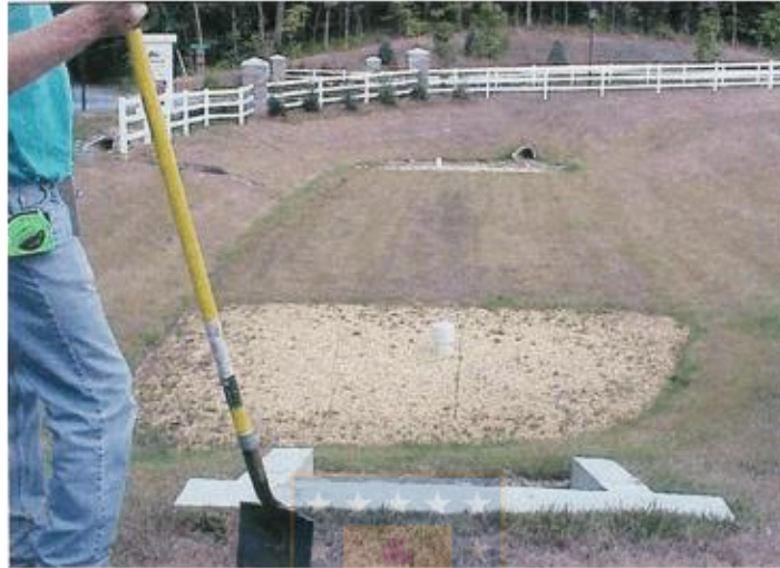
Figura 3.- Estanque seco ( Dry Pond ) en Estados Unidos
