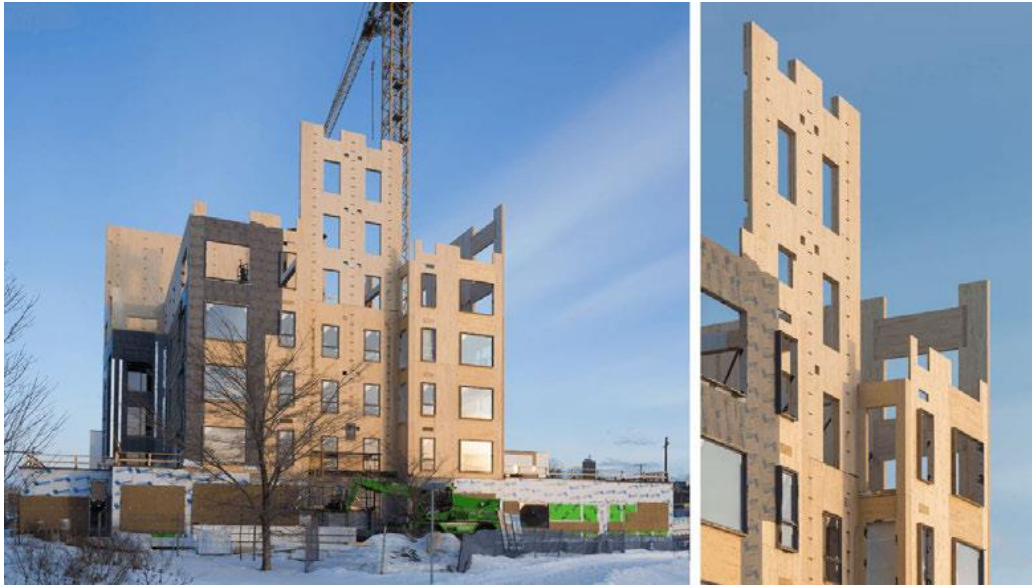
Figura 2.6 Estructura tipo Ballon Frame. (FPInnovations, 2019)
