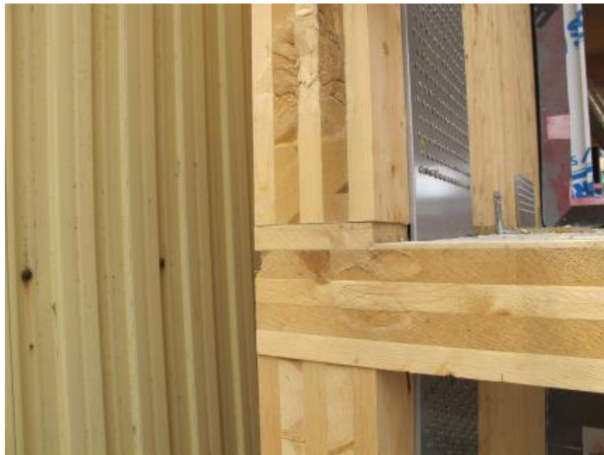
Figura 2.7 Estructura tipo sistema plataforma. (FPInnovations, 2019)
