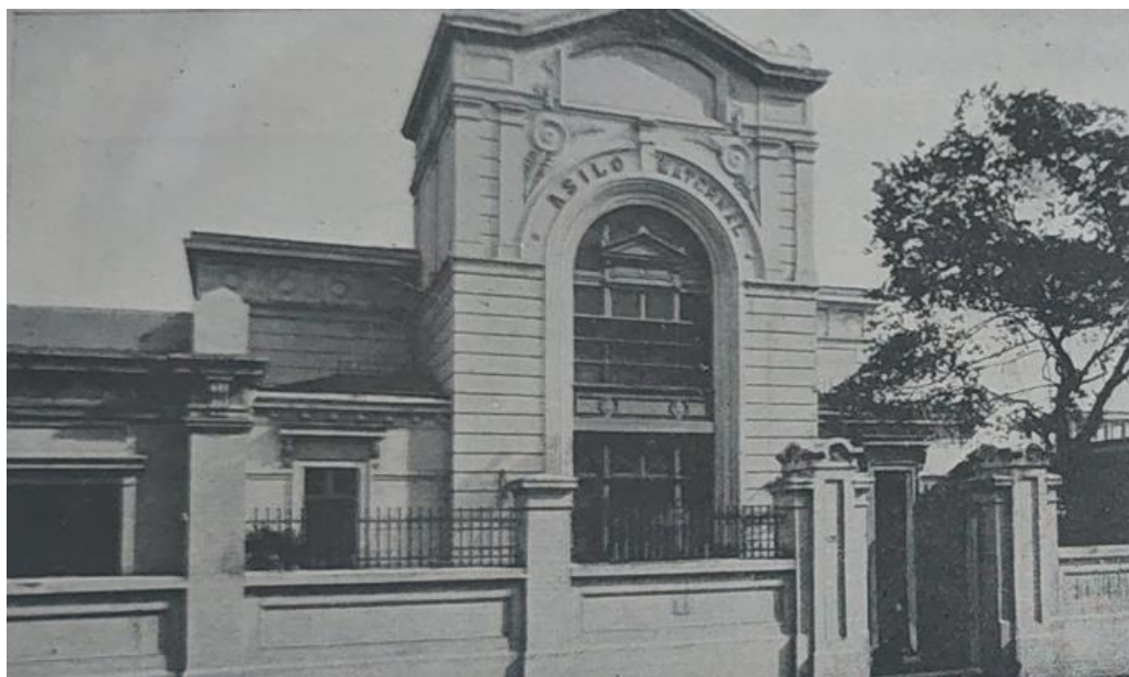
Ilustración 36: Fachada del Asilo Maternal
