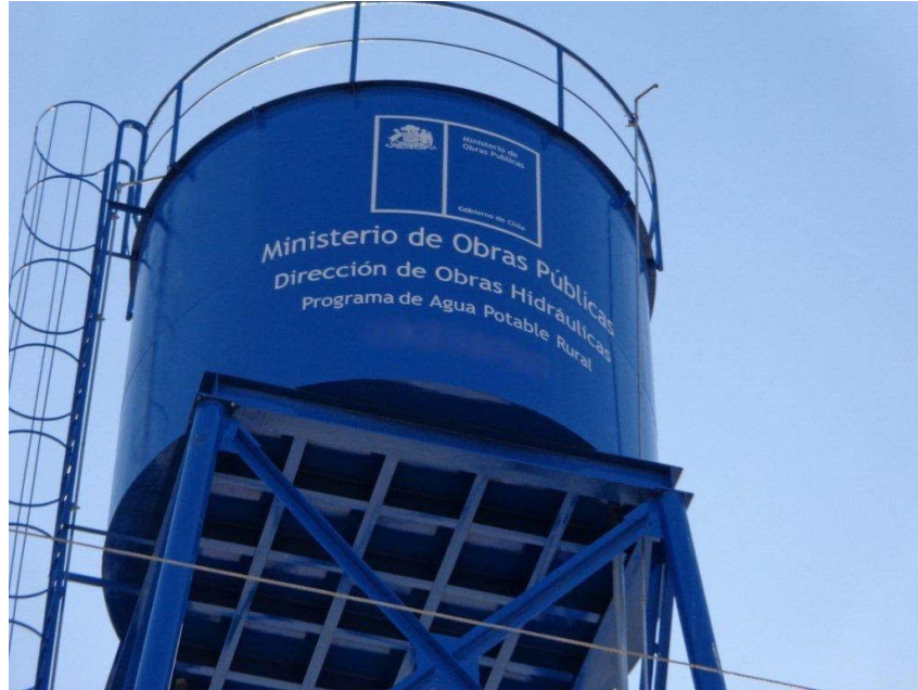
Imagen 10. Fotografía de referencia de una planta de Agua Potable Rural.
