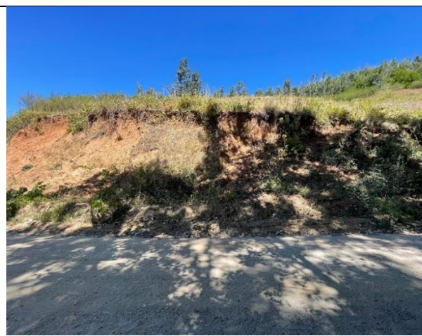
Deslizamiento de tierra en sector Chillancito
