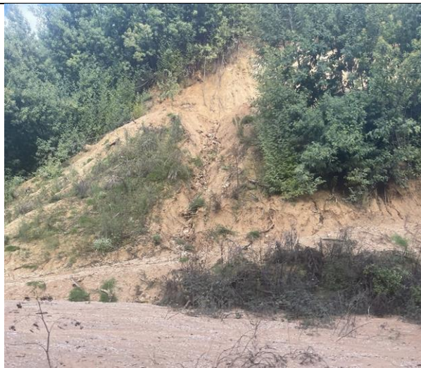
Deslizamiento de tierra en sector Maqueuto
