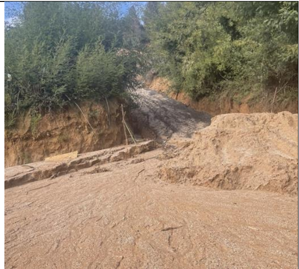
Caída de rocas en sector Maqueuto
