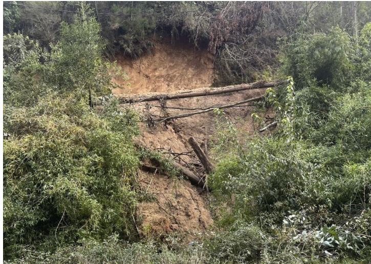
Figura 10. Ejemplo de deslizamiento rotacional de tierra en sector Paso de Piedra/Maqueuto.
