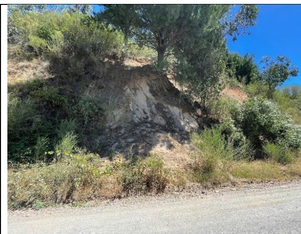
Caída de rocas en sector Chillancito
