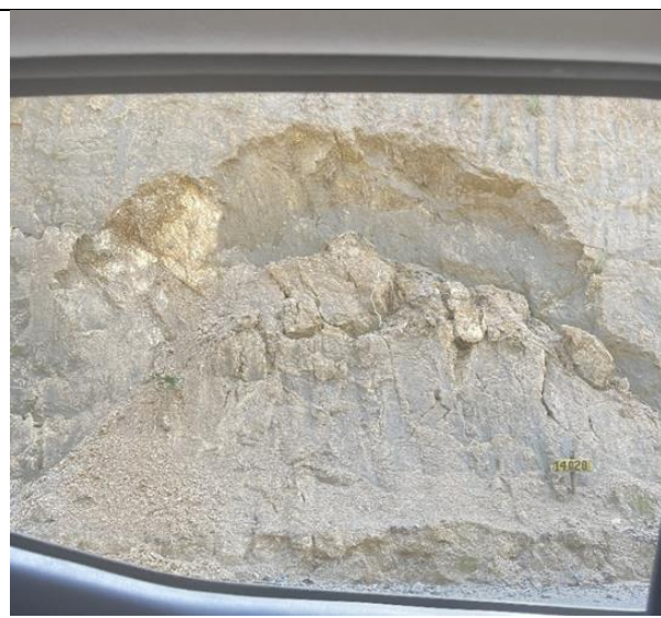
Deslizamiento de tierra en sector Maqueuto
