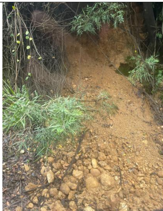
Deslizamiento de tierra en sector Redolino
