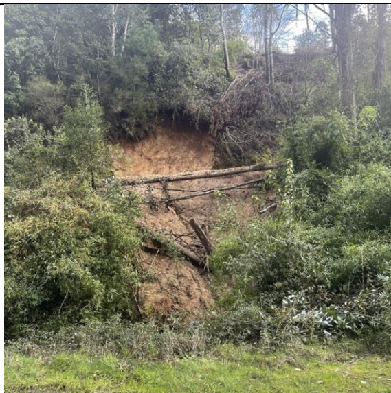
Deslizamiento de tierra en sector Lo Vargas
