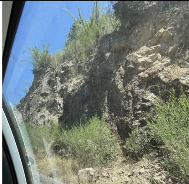
Deslizamiento de tierra en sector Chillancito
