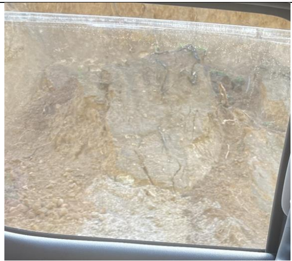
Caída de rocas en sector Maqueuto
