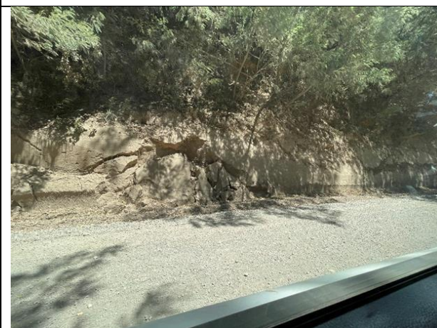
Deslizamiento de tierra en ruta 0-722, sector Bulnes
