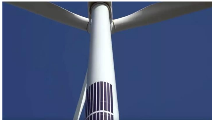
Figura 2.14: sistema híbrido eólico solar, del grupo ACCIONA. (Extraído de [35])
