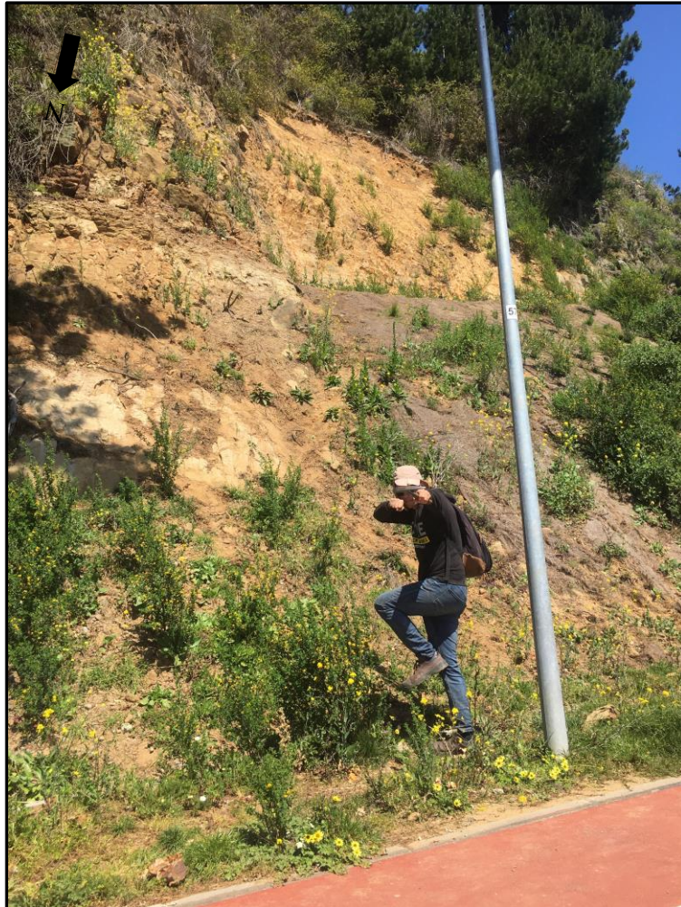
Fig. 13: Foto de afloramiento de Fm Curanilahue sobre la ciclovía frente a la bahía, sureste del área de estudio, (Punto 1).
