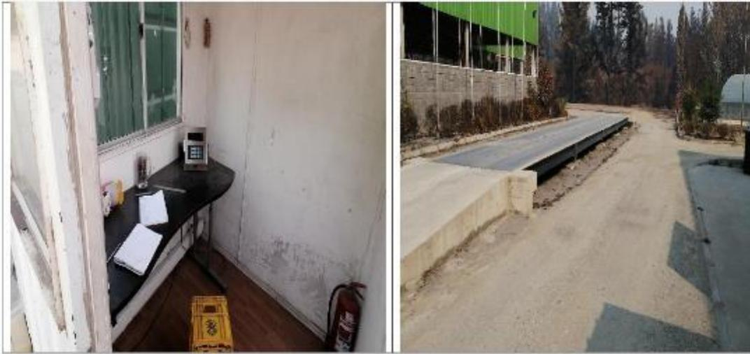
Fotos 29 y 30: Sistema de registro de pesaje y balanza operativa, sin daños
