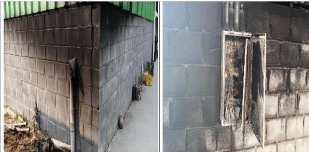
Fotos 23 y 24: Detalle de falla en material tipo hormigón y del box de distribución eléctrica del galpón de reciclaje
