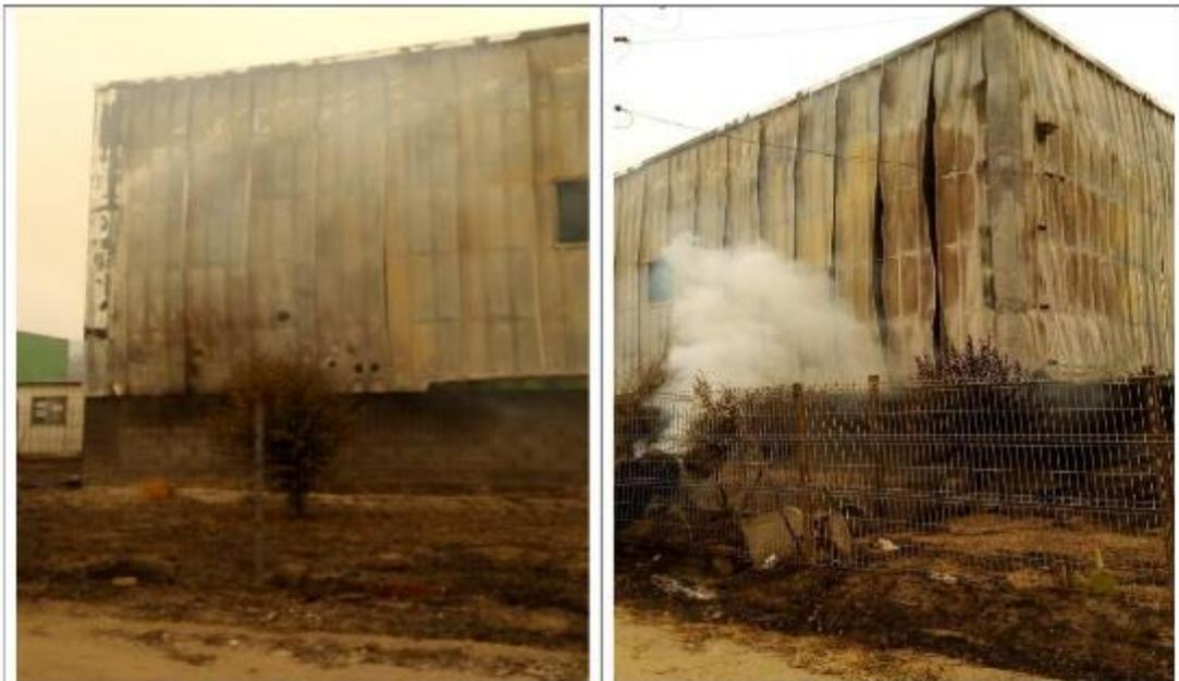
Fotos 7 y 8: Vistas externas del galpón mostrando daños en la cubierta
