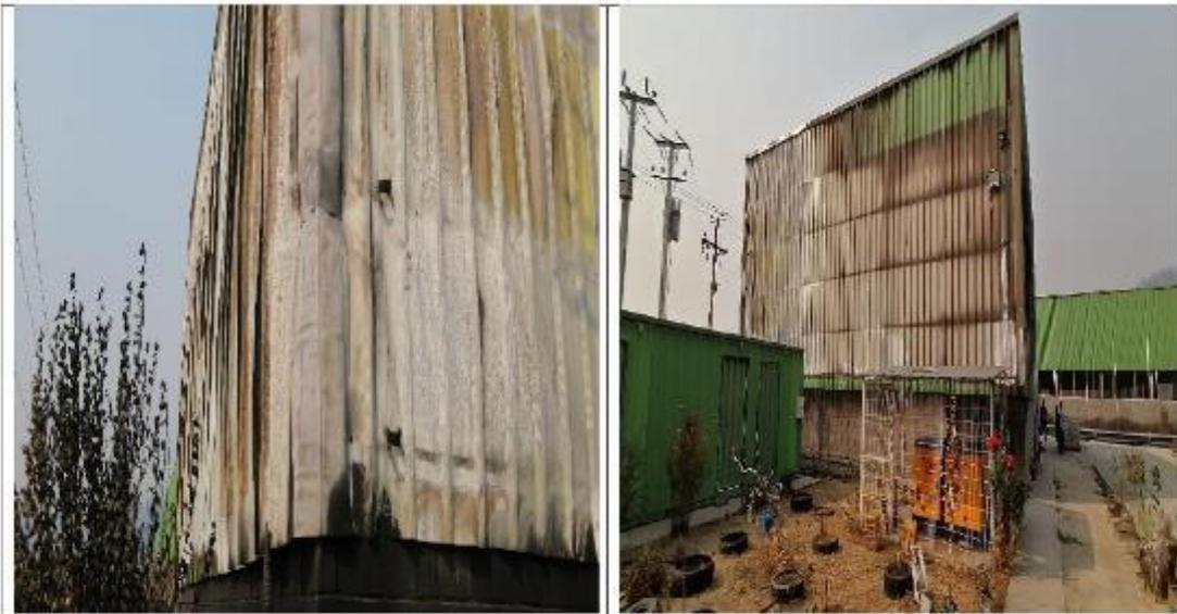
Fotos 19 y 20: Vistas externas del galpón de reciclaje detallando daños en las cubiertas de hojalata
