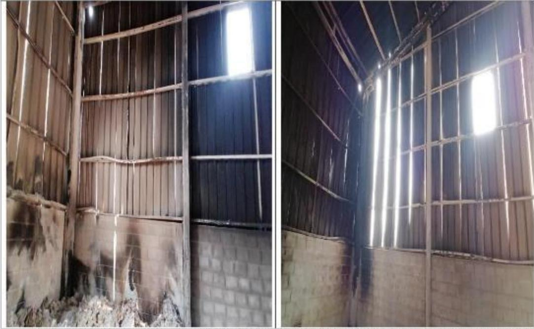
Fotos 21 y 22: Vistas interiores del galpón de reciclaje mostrando deterioro de las estructuras metálicas
