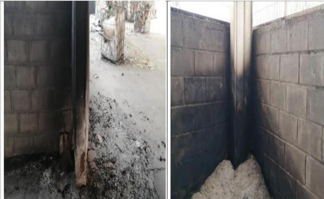
Fotos 25 y 26: Daños por el fuego en vigas maestras del galpón de compostaje
