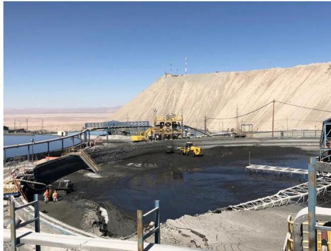
*Figura 18. Espesador T5, acumulando flujo rebosado de los espesadores de cabeza C6 y C7 (Elaboración propia).*
