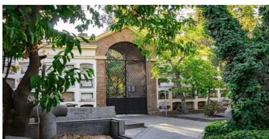
Anexo 76: fotografía de la entrada al patio de los disidentes en Santiago, construido en 1854. Con siete metros de alto y tres de ancho, este muro marcaba una separación con el cementerio católico.
