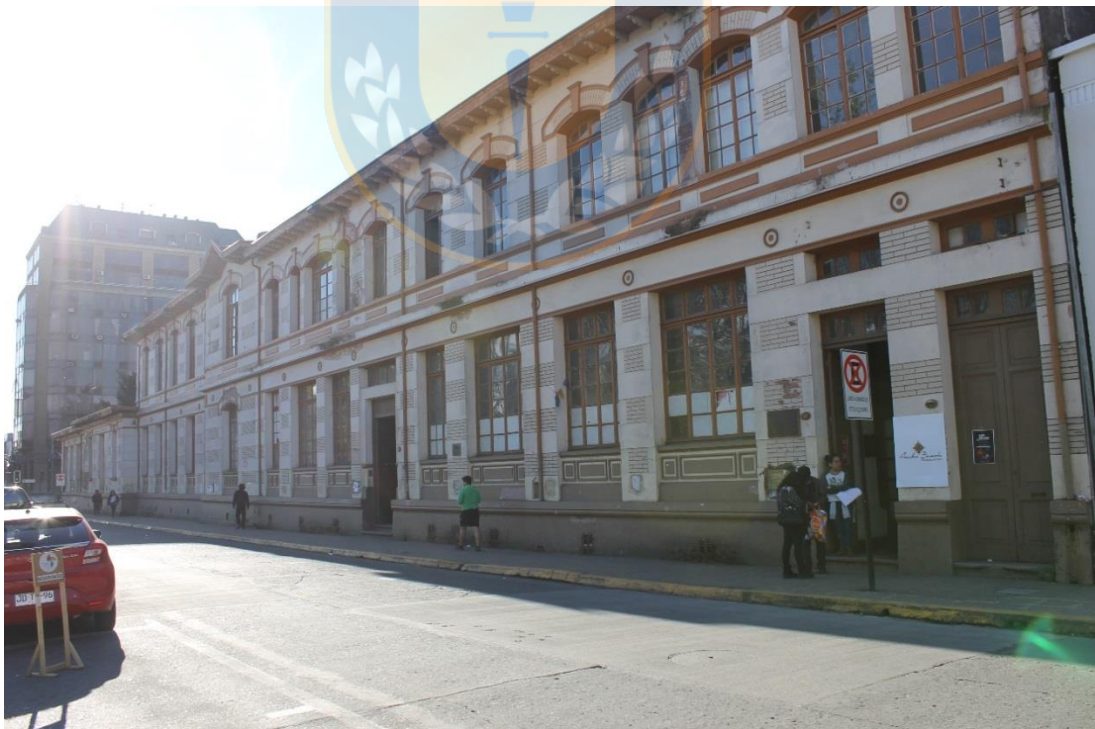
Liceo de Hombres antes de las intervenciones, elaboración propia
