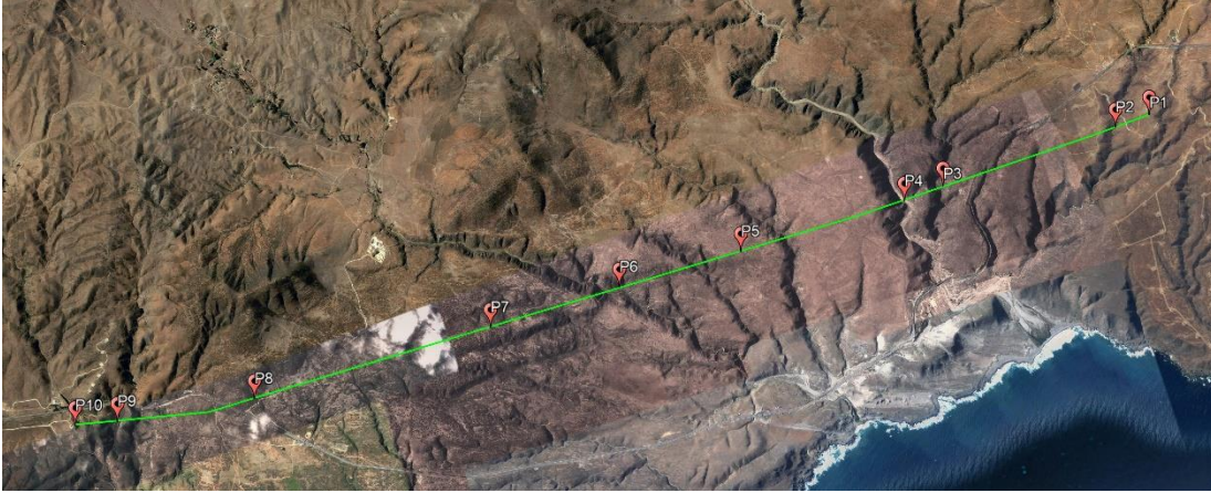
Fig. A.5 Ubicación geográfica y vanos monitoreados para línea Talinay-L. Cebada. Fuente: Elaboración propia.
