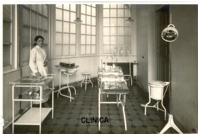
Figura 46. Clínica refinería CRAV, sala de maternidad, en la década del 30. (Archivo fotográfico, Museo de la Historia de Penco)
