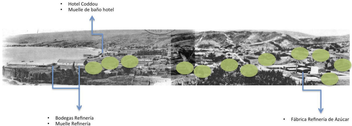
Figura 11. Intervención sobre montaje, espacios sociales y productivos refinería. (Elaboración propia, 2018)
