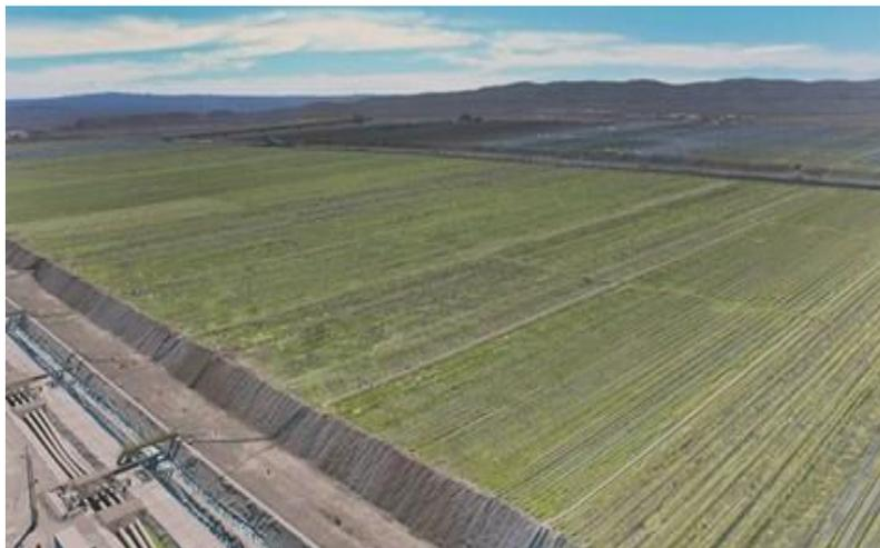
Figura 1: Pilas de lixiviación dinámica en Minera Antucoya. [4]
