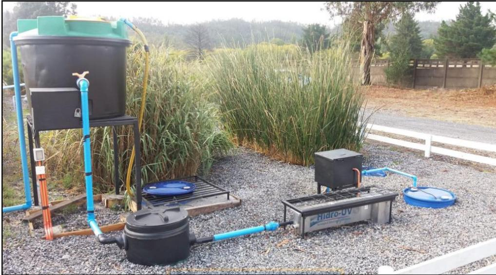
**Figura 10.** Sistema UV a escala piloto ubicado en PTAS de la comuna de Hualqui.
