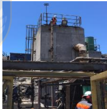
Figura 30: Ascenso de personal al estanque TK17
