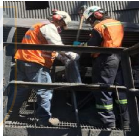
Figura 51: Traspaso de material de correa a bolsas.
