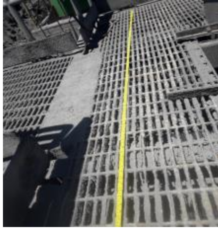
Figura 31: Medición de dimensiones en parte superior del estanque
