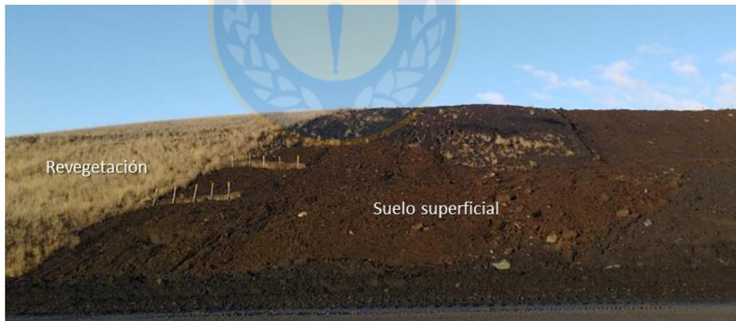
Figura 4.21: Talud parcialmente rehabilitado
