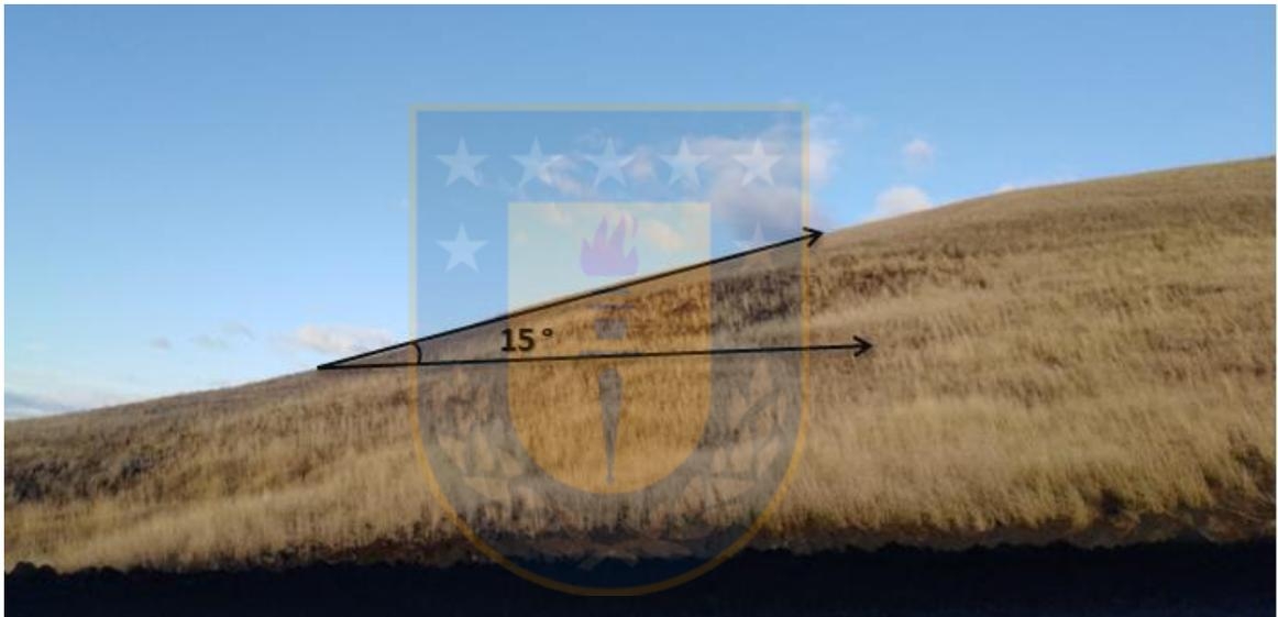
Figura 3.7: Talud resultante luego de operaciones de rehabilitación.
