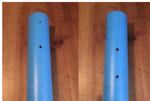
Figura 18: Confección de los orificios en la tubería de PVC para el posicionamiento de los sensores.
