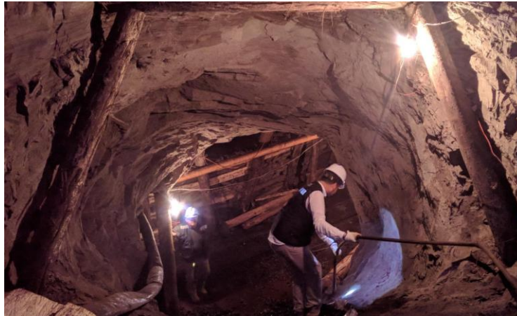
Figura 4: ejemplo de estocada inclinada que conecta dos maestras.
