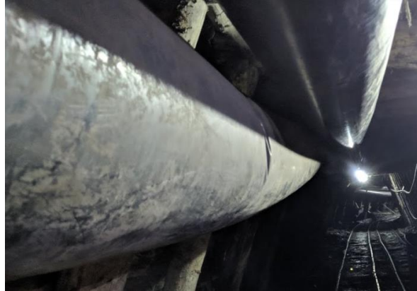
Figura 21: ductos flexibles en minería artesanal.
