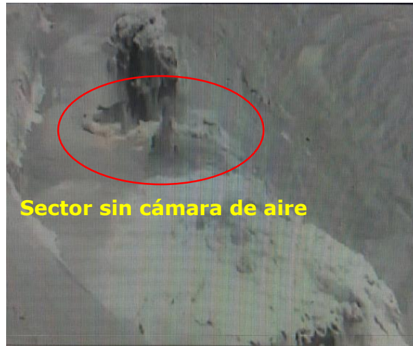
Figura 30: Tronadura sección sin cámara de aire
