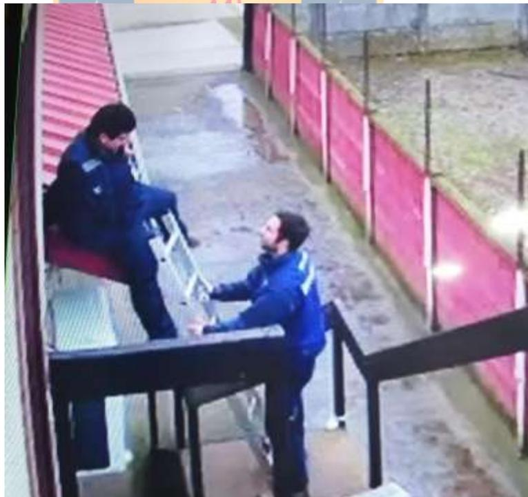
Se evidencia, la realización de trabajo en condiciones inseguras, mediante acciones inseguras por parte del personal, falta de implementos de seguridad al momento de realizar trabajos en altura, herramientas eléctricas sobre escaleras, condiciones climáticas incompatibles con tareas asignadas.
