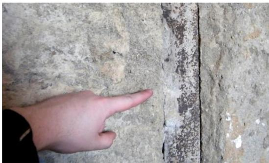
Fig. 5. Detalle de junta perfil-relleno, acusando fisura.
