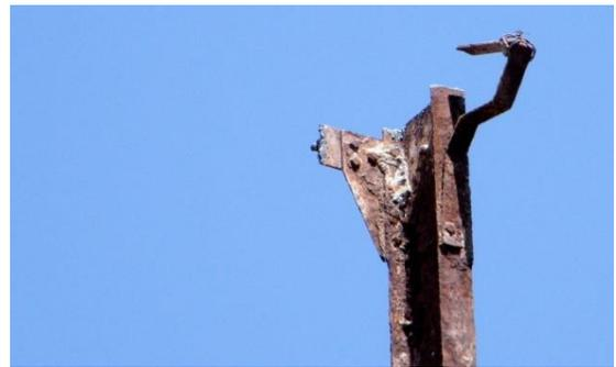
Fig. 6. Detalle de unión pilar-viga y pértiga que conforma la cornisa.
