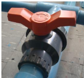
Fig. C.14. Válvula PVC
