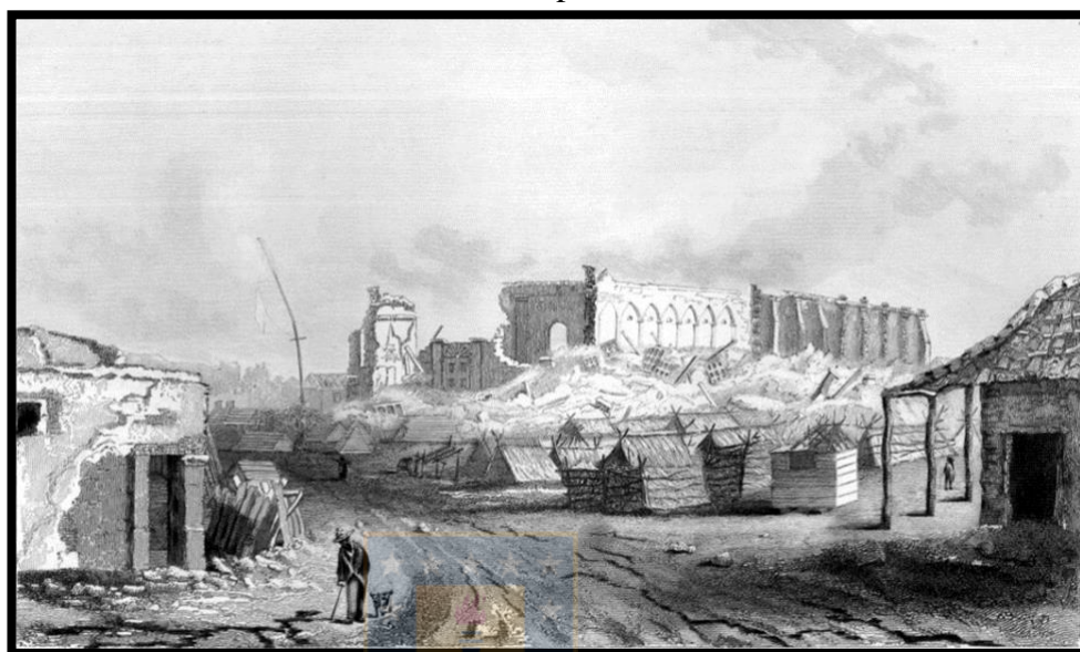
FIGURA 8 Restos de la catedral de Concepción tras el sismo de 1835
