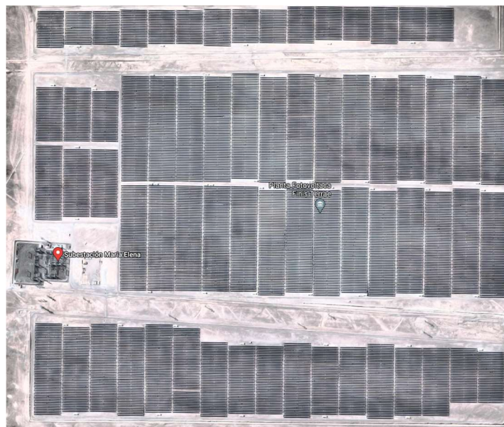
Fig. 4.12 Vista aérea de la planta solar fotovoltaica Finis Terrae (72.8MW).
