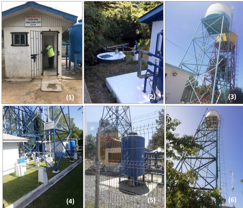
Figura 6. APR visitados. (1) “Villa Juan Riquelme” (sala de desinfección) – (2) “Caleta Chome” (captación y sala de desinfección) – (3) “Canteras - El Hualle” (estanque de almacenamiento) – (4) “Chillancito de Cabrero” (estanque, sala de desinfección y filtro) – (5) “El Olivo” (filtro, sala de desinfección y estanque de almacenamiento) – (6) “Charrúa” (estanque de almacenamiento).
