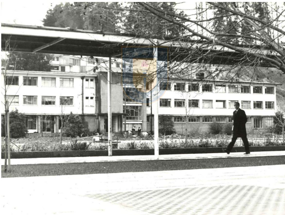
Fig. 23. Imagen de paso cubierto. Registro fotográfico aportado por el arquitecto Gonzalo Rudolphy, sin data.
