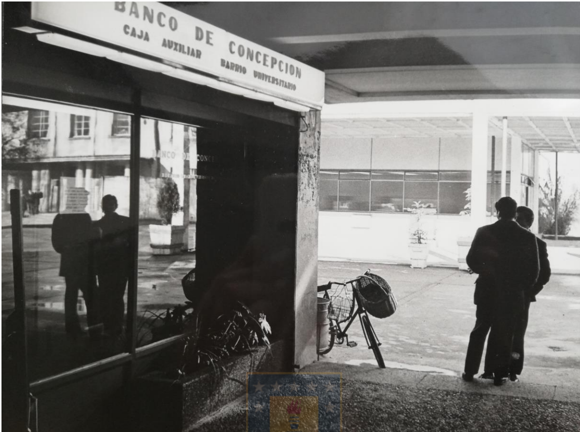
Fig. 33. Imagen interior. Registro fotográfico aportado por arquitecto Gonzalo Rudolphy, sin data, donde se aprecia el interior de la Galería interior del Foro. Posiblemente previa a la instalación de pavimentos de Plaza de Acceso.
