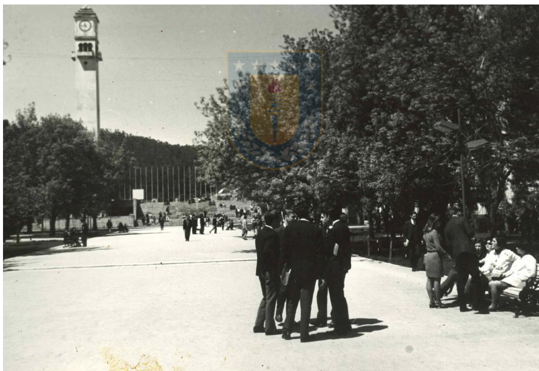
Fig. 69. Registro fotográfico aportado por el Arquitecto Gonzalo Rudolphy S. sin data. Es posible apreciar caseta de Proyecciones, desaparecida en la intervención del año 2000.
