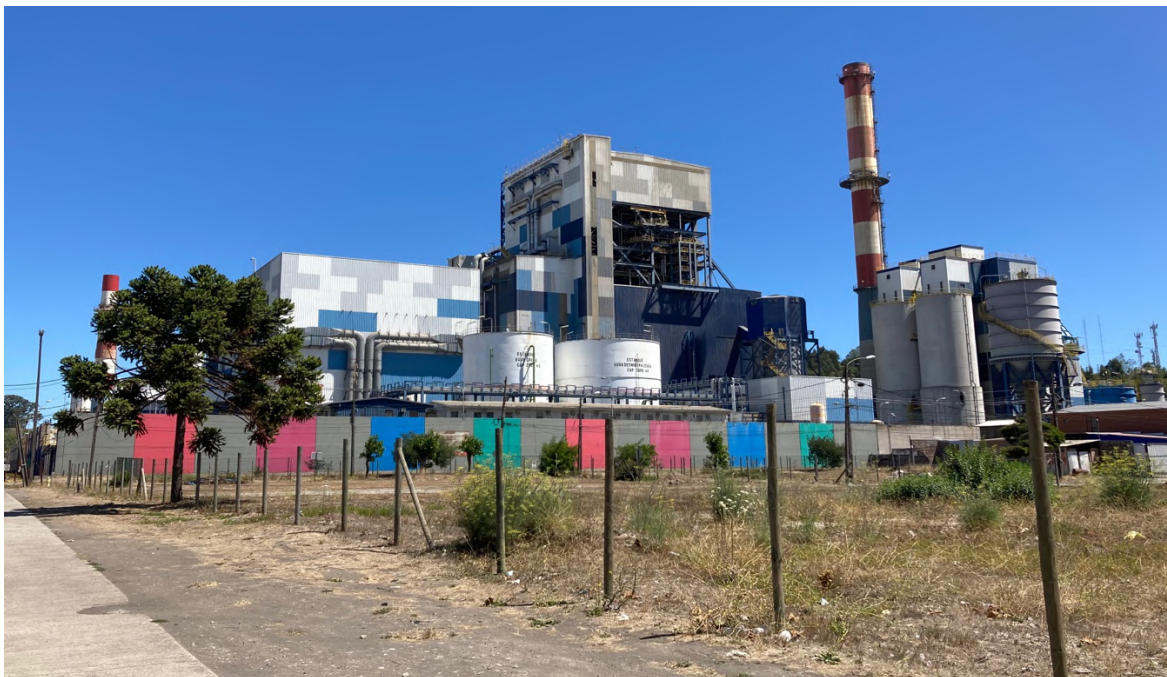
Fotografía N°11. Termoeléctrica Bocamina II de ENEL (Febrero 2022)
