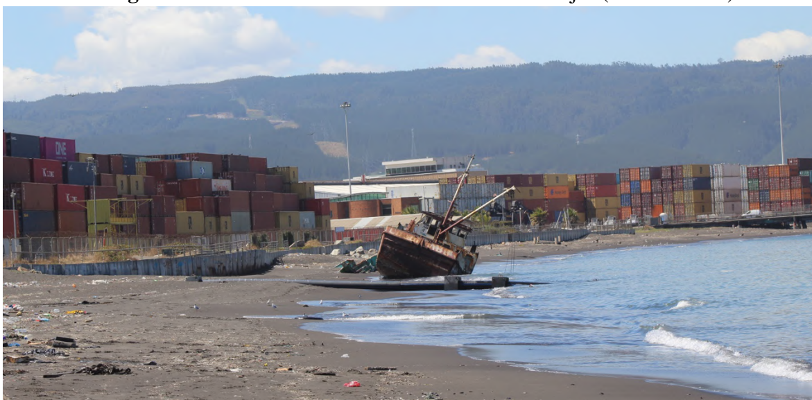
Fotografía N°3. Puerto de Coronel desde Caleta Lo rojas (Febrero 2022)
