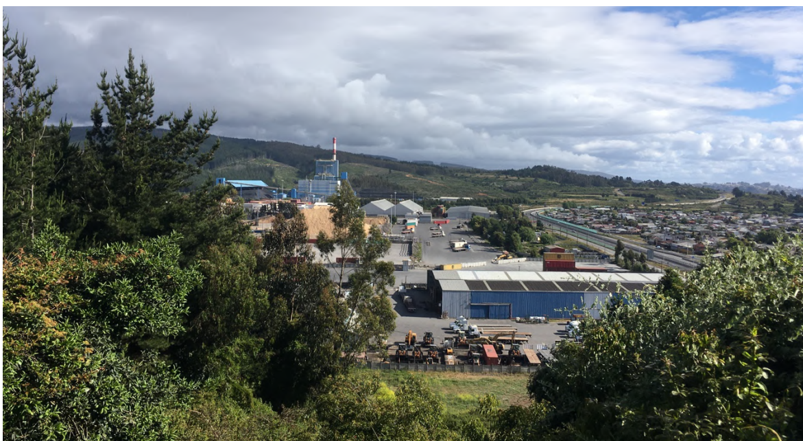
Fotografía N°12. Termoeléctrica Santa María e instalaciones portuarias desde Cerro Corcovado, Sector Manco (Noviembre 2021)
