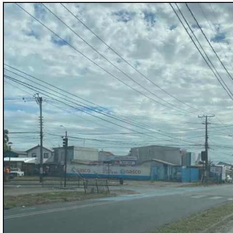
Imagen 97. Ciclovía Calle Enrique Soto intersección Av. Las Torres.
