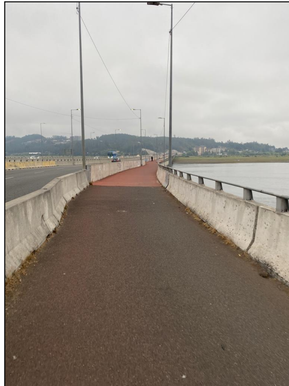
Imagen 84. Tramo Puente Bicentenario.
