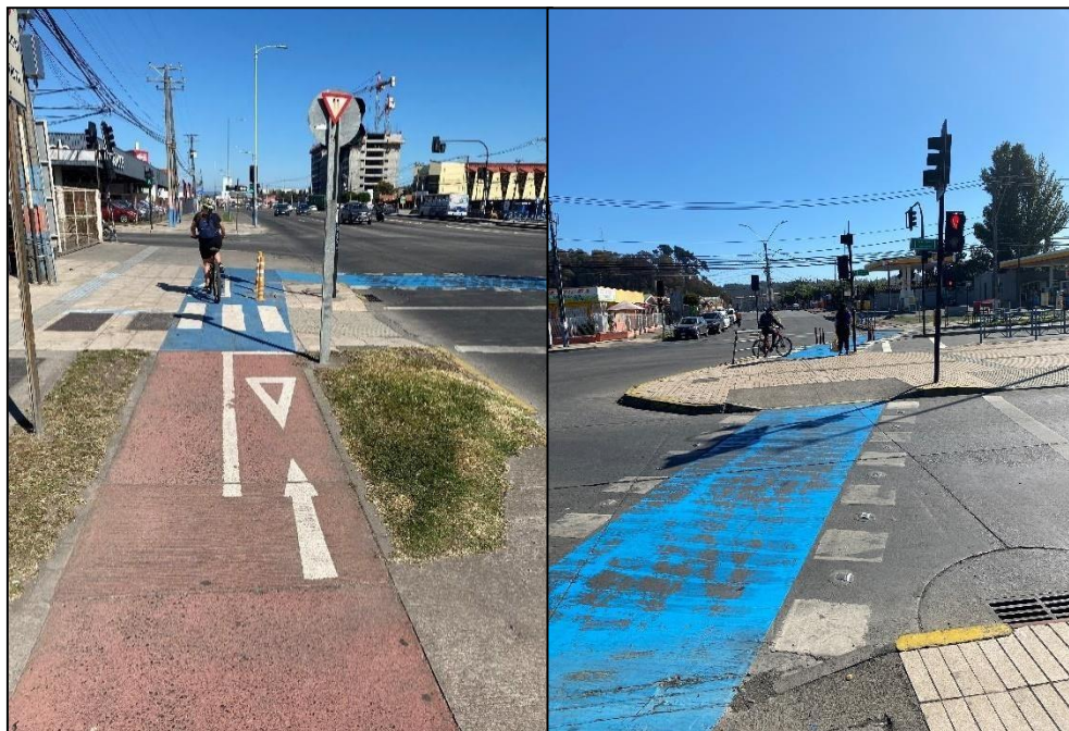
Imagen 129. Tramo ciclovía Av. Colón – intersección Calle Desiderio García.
