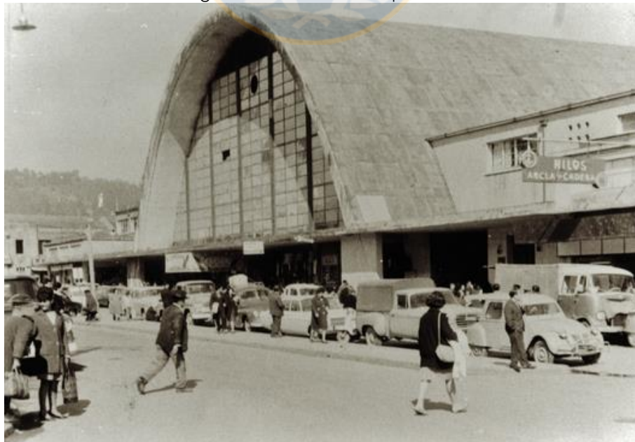
Imagen 17: MCC calle Caupolicán
