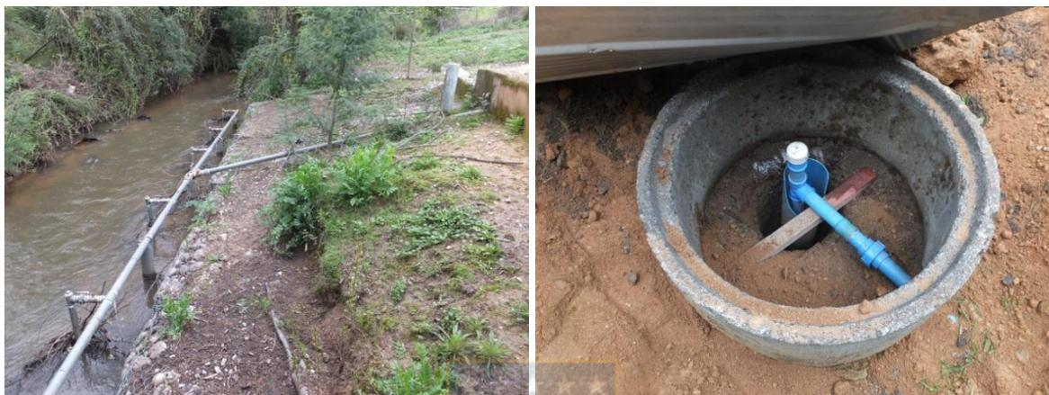
**Figura 2.** Izquierda, captación superficial (punteras) estero Chaimávida, sistema APR DOH Chaimávida Soto, Comuna de Concepción. Derecha, puntera APR Externo Pissis, comuna de Tomé. Fuente: Fotografías del autor.
