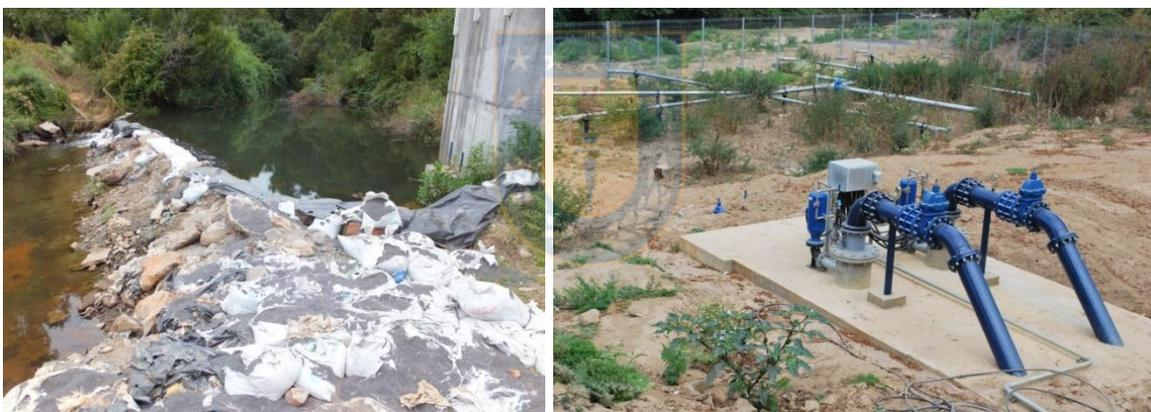
**Figura 49.** Izquierda, captación superficial Los Tilos ESSBIO, estero Bellavista, comuna de Tomé. Derecha, sistema de punteras, río Pingueral ESSBIO, Dichato, comuna de Tomé. Fuente. Fotografías del autor.
