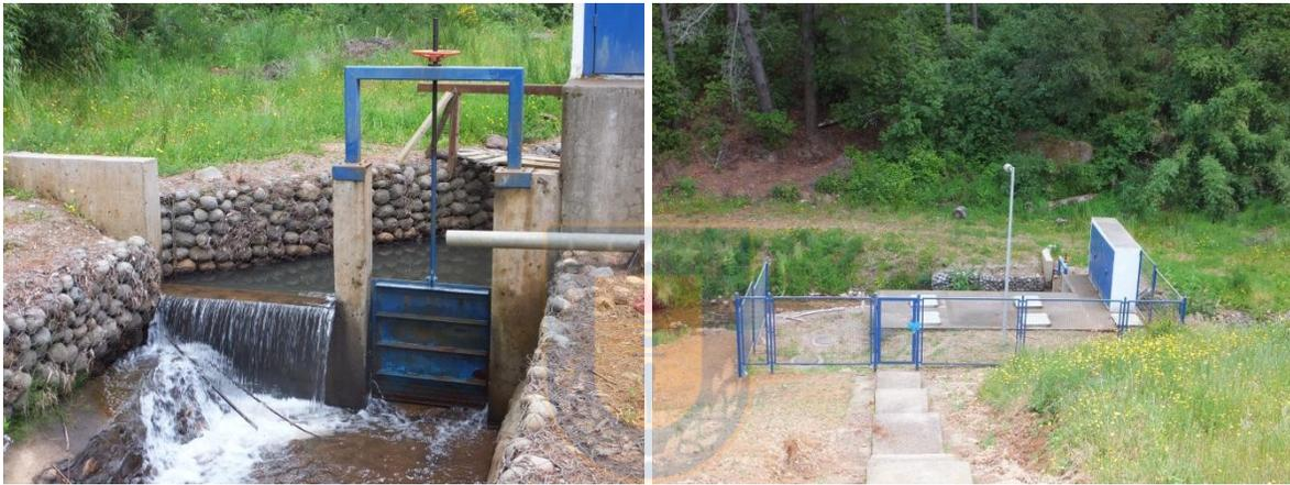
**Figura 7.** Izquierda, captación superficial, sistema APR DOH Pichiarauco, Comuna de Curanilahue. Derecha, vista panorámica de la misma captación. Fotografías del autor.
