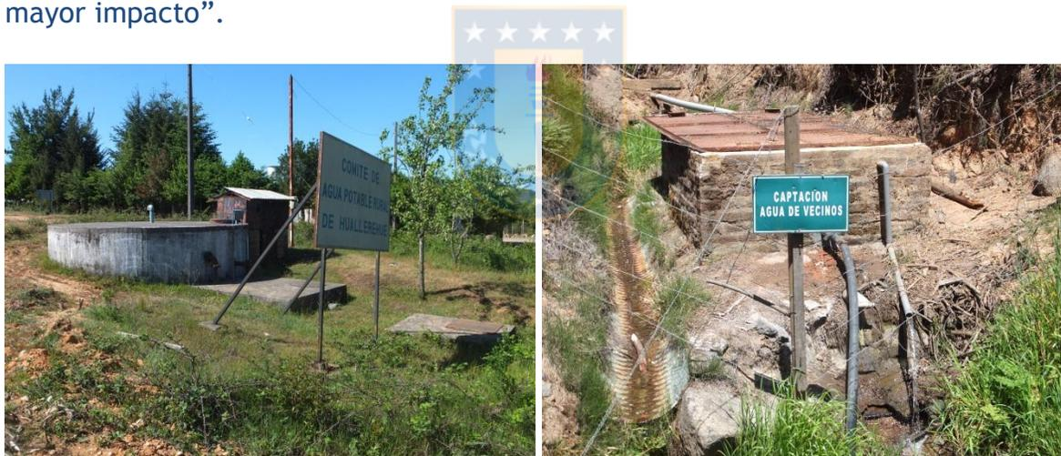
**Figura 1.** Izquierda, estanque sistema APR DOH Huallerehue, Comuna de Santa Juana. Derecha, captación, sistema de APR Externo Curalí, comuna de Santa Juana. Fotografías del autor.
